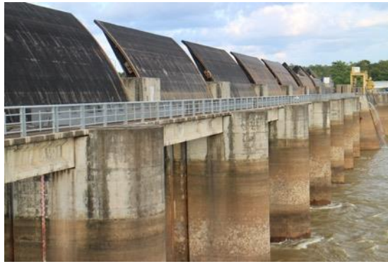
図 4: 水門を開いた状態のパクムンダム
