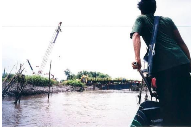
図 7: サイトの建設工事現場(2000 年撮影)
