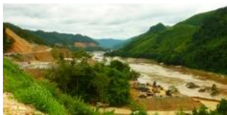
进展中的沙耶武里大坝建设（2012 年 7 月、 照片提供：International Rivers）
