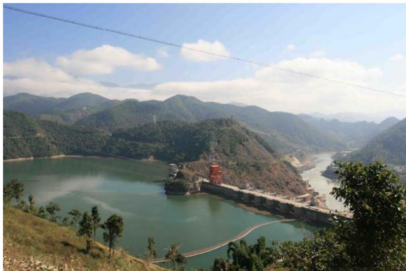
漫湾ダムは、中国領内でのメコン川流路約 2000km の中ほどに建設された水力発電施設である。特筆すべき点は、メコン川全流域を通して初めて本流を堰き止めた大型ダムであり、中国領メコン開発計画の第 1 号として建設されたことだ。総貯水量 9 億 2000 万 t、有効貯水量 2 億 5200 万 t、発電能力 1500MW の規模を誇り、電力は雲南省内で使われている。
