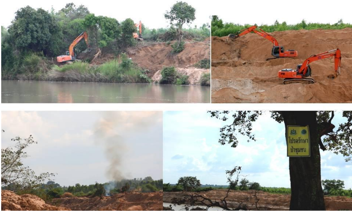
ภาพการขุดลอกกริมตลิ่งแม่น้ำมูล บริเวณ ต.หนองแค อ.ราชীไศล จ.ศรีสะเกษ เดือนสิงหาคม 2558
