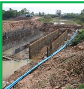
堰の建設と工事 想定していた問題
