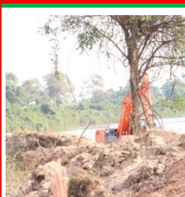
「護岸」工事 想定していた問題/ 住民も強い懸念
