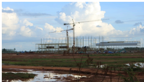
写真7：建設中の製糖工場
