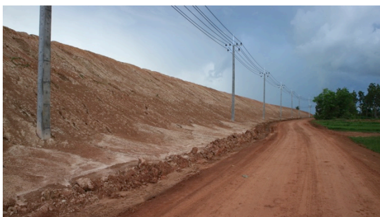
写真6：敷地を取り囲む盛り土
