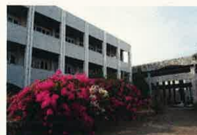
建物外観（東側エントランス）
