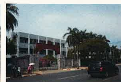
建物外観（敷地出入り口）
