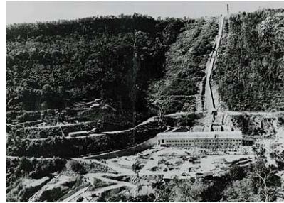
バラーチャウン第二水力発電所改修事業
